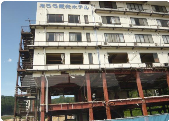
宮古市田老地区(たろう観光ホテル津波被害跡)
